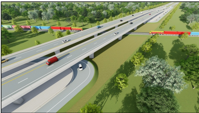
รูปที่ 5-1 จุดกลับรถใต้สะพาน
