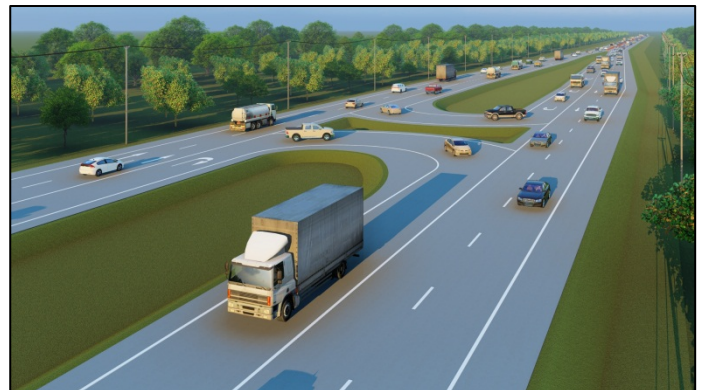
รูปที่ 5-2 จุดกลับรถบริเวณเกาะกลางถนน รูปแบบหยดน้ำ
